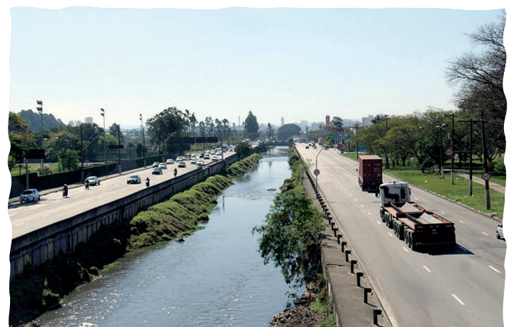
Avenida dos Estados
