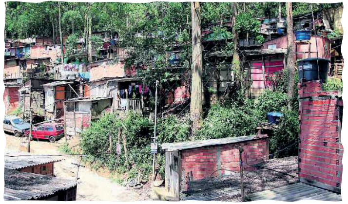
Parte da estrada da Cata Preta, na Vila Luzita
